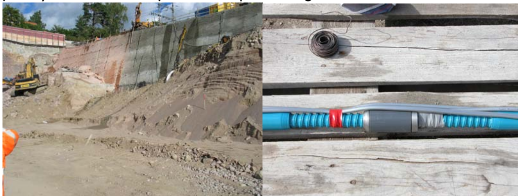
Foto visar schaktväggen resp. jordspik med en mätpunkt.
